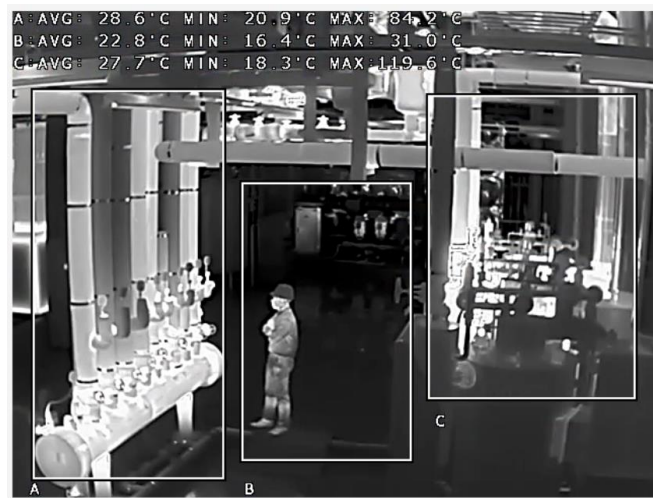
[그림 12. ROI 영역별 평균, 최대, 최저 온도 모니터링 예]
